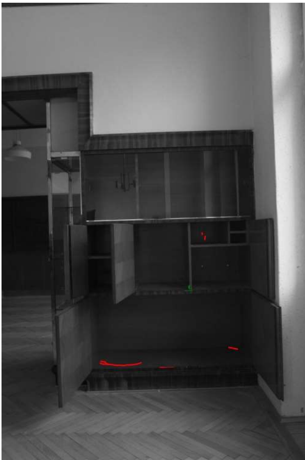
Mapa poškození, dělicí stěna pravá, otevřená
