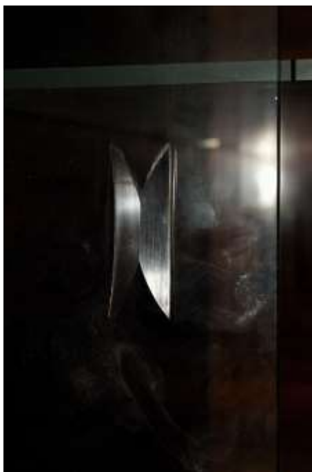
Detail výbrusu ve skleněných šoupacích dvířkách
