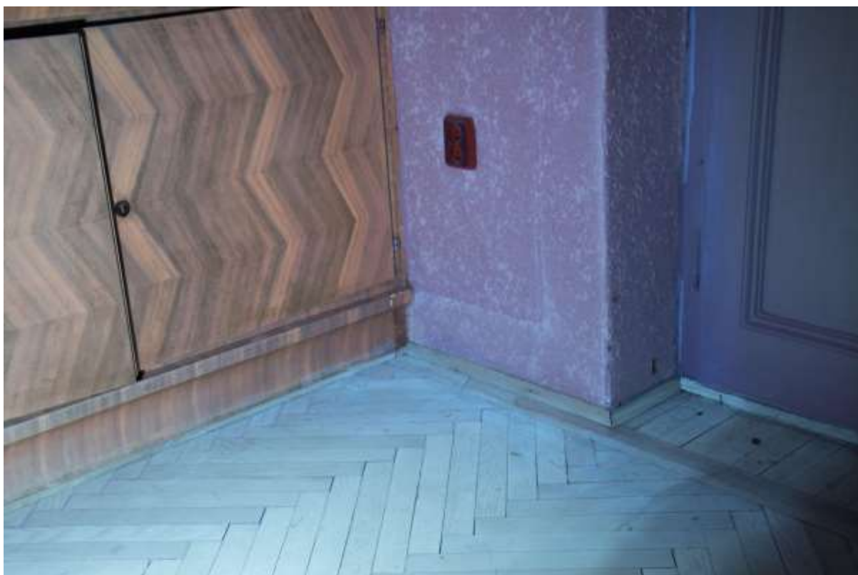
Stopa po odstraněném obkladu na stěně
